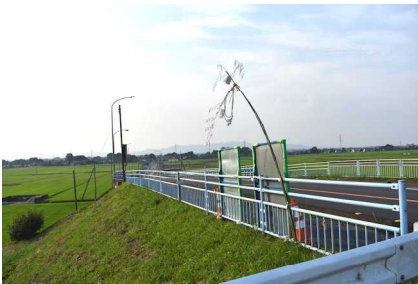
①野木との境(松原大橋西)
