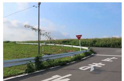
⑨西生井との境(閘門東)
