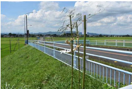
①野木との境(松原大橋西)
