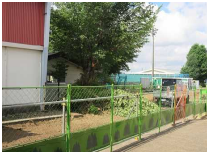
樹木伐採と防護策設置 (7/29)
