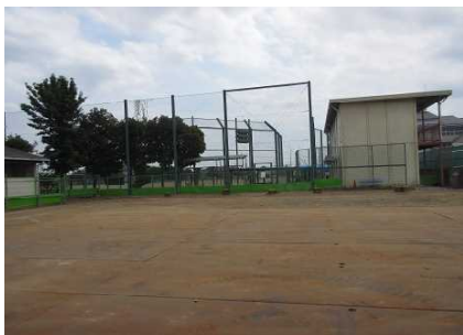
フェンス側樹木伐採 (8/10)
