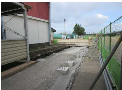
廊下の基礎部分 (9/6)
