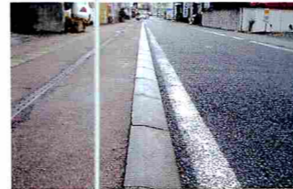
段差を少なくした歩道
